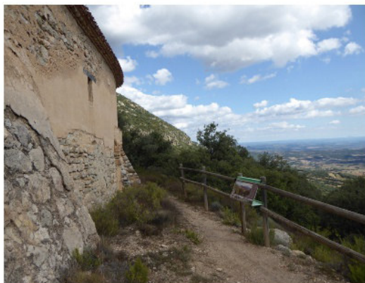
Visió del mirador i dels contraforts de la paret sud de l'ermita.
