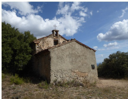
La façana oest de la humil però personal ermita de sant Sebastià.
